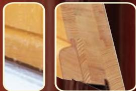
**Exzellente Wasserabführung** bei Wind und Wetter. Der Wetterschenkel ist nicht wie bei vielen anderen Türen nur aufgeklebt, hinter dem sich gefährliche Staunässe und somit Fäulnis bildet, sondern technisch perfekt und (nur bei mb-Haustüren) „nahtlos“ integriert. **ACHTUNG: Modellabhängig auch ohne Wetterschenkel**
